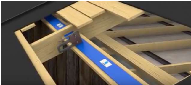
Kuva 3. Kiinnitä palokatkonauha ruostumattomilla hakasilla, ruuveilla tai nautoilla nauhan keskilinjaa pitkin max. 250 mm etäisyydellä toisistaan ja max. 150 mm etäisyydelle nauhan päädyistä. Käytä 14 mm ruostumattomia hakasia, tai ruuveja / nautoja, joiden kannan halkaisija on max. 11,5 mm.
